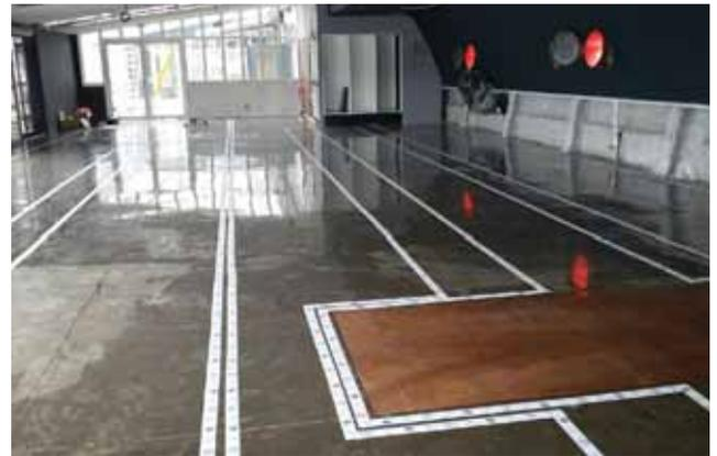
*Défi technique: installation d'une boucle d'induction magnétique sur une barge.*
